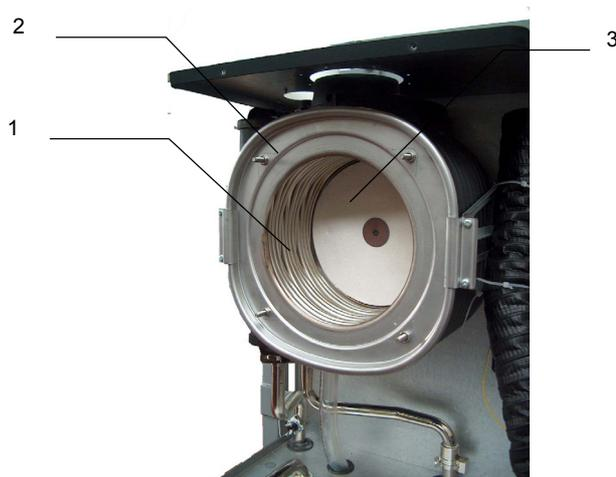
Figura 4-2 pulizia dello scambiatore termico a condensazione
